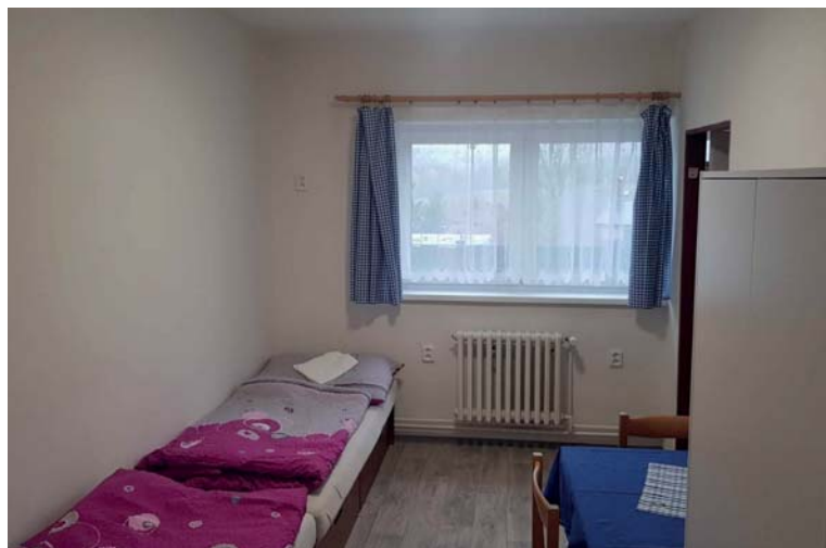
Foto z rekonstrukce a po ní: SK Zásada
